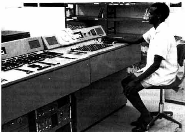
NF-Verteilung, Fernsteuerungsanlage und Senderegie Kigali
