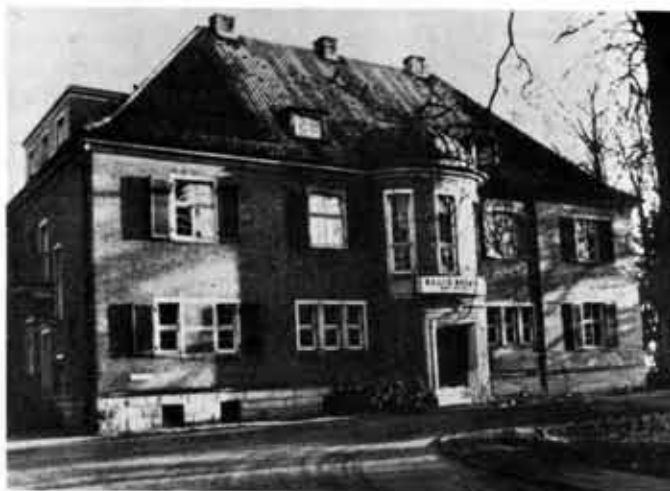
Das erste „Funkhaus“ – eine beschlagnahmte Villa in der Schwachhauser Heerstraße.
