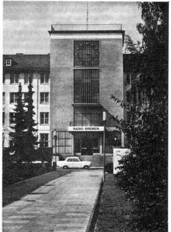
Haupteingang des Funkhauses
