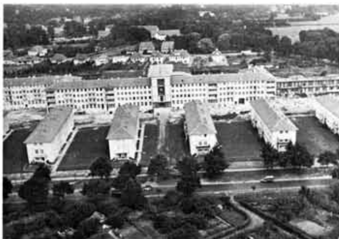
Bauarbeiten am neuen Sendegebäude in der Heinrich-Hertz-Straße.
